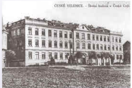
Původní školní budova
