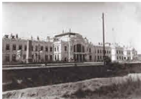
Nové secesní nádraží postavené v roce 1909
