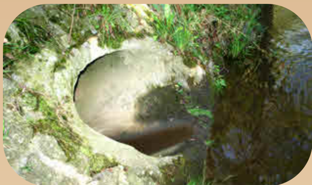
Šachta z příběhu
