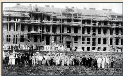
Stavba školy č. 325 v České Cejli
